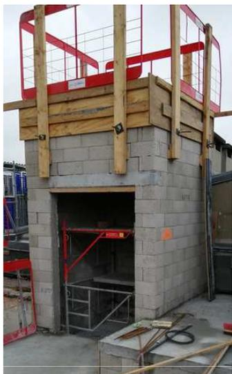
Finition de la construction de la cage d'ascenseur Nord
