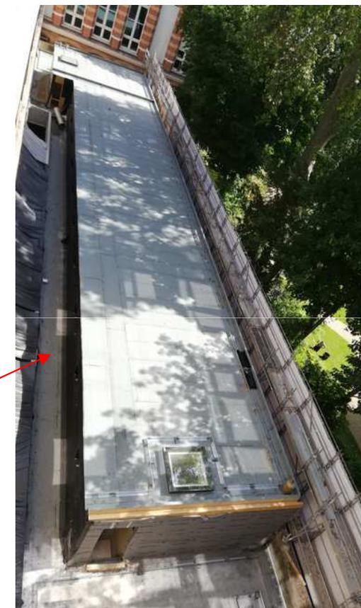
Finition de la pose de l'étanchéité du R+1 :
