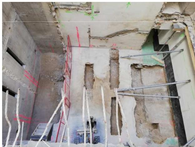
Sciage des semelles sous-fondations et terrassement pour les cuvettes d'ascenseur
