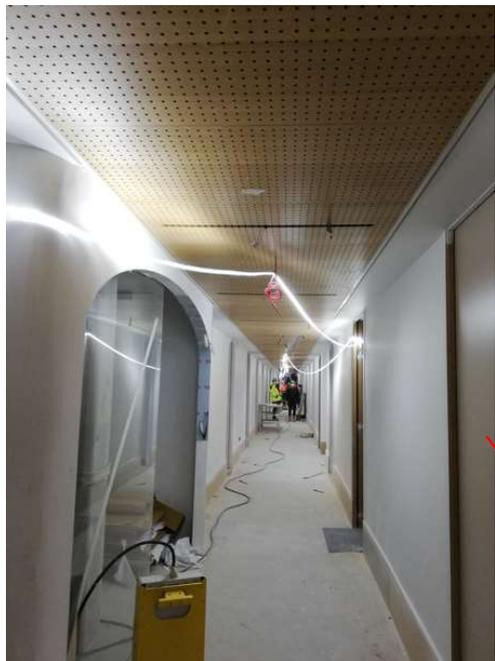
Travaux de peinture, ragréage, pose des faux-plafonds, du revêtement de sol et pose des menuiseries intérieures,...
