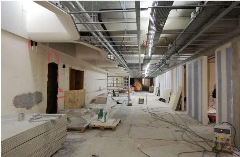
Caissons staff finalisés, pose des réseaux de ventilation et de chauffage, des cloisons, début de pose des faux-plafonds.
