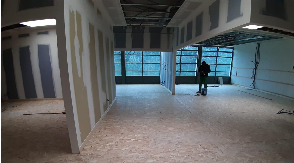
Achèvement de la pose des planchers des futures salles de réunion
