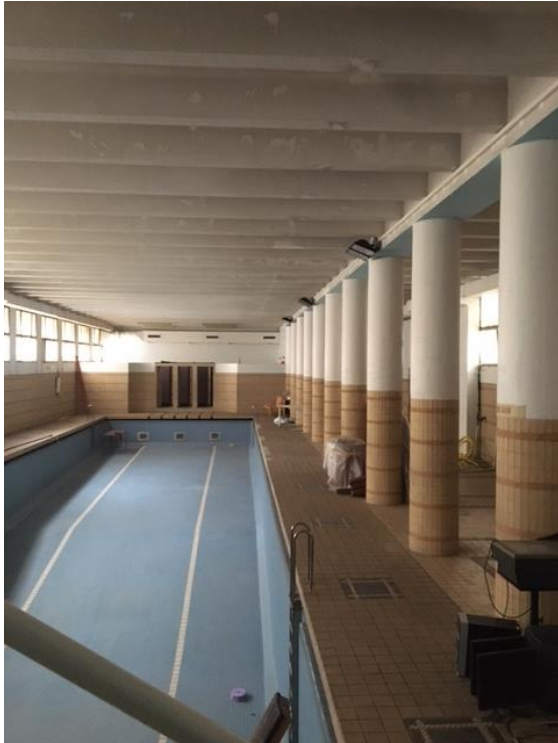
1 er sous sol Piscine
